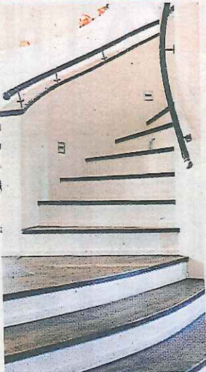
Trappan upp till övervåningen är murad och känns gedigen på ett sätt som är ovanlig i vanliga villor.
